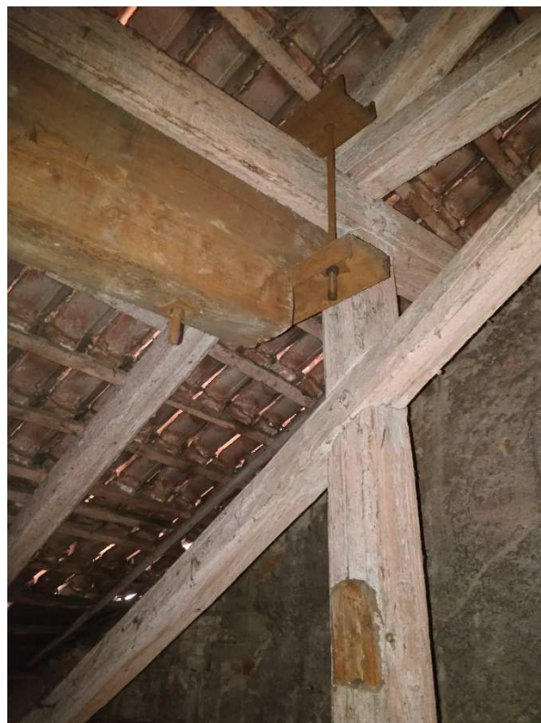
02 – Detail podvěšení posilujícího průvlaku
