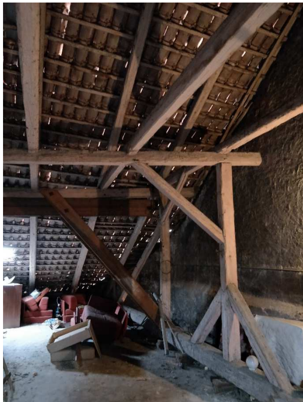
01 – Pohled na SZ roh a posílení krajní vaznice
