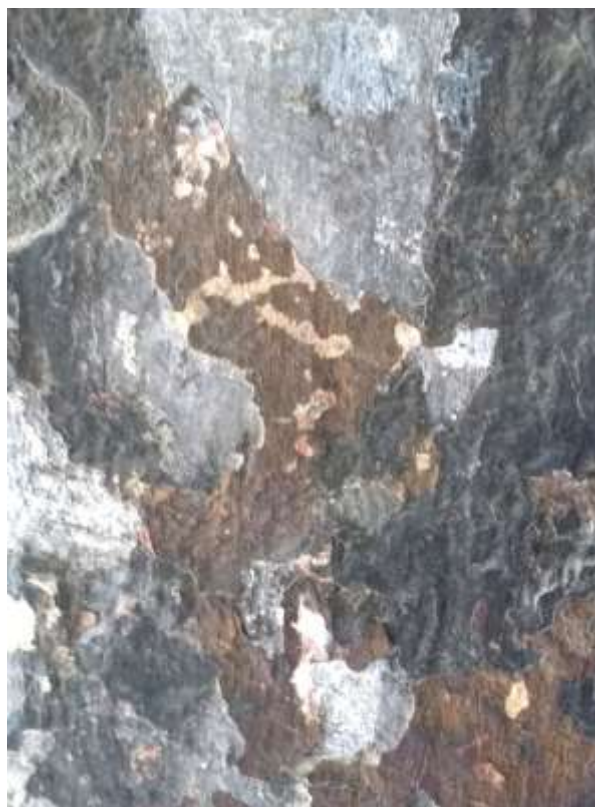
32. Portál vedoucí na balkón do dvora, zbytky polychromie (šedá, červená, okr), částečně přetažené cementovou stěrkou
