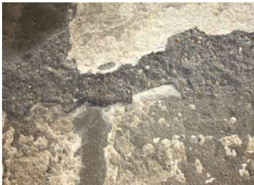
30. Hrubší a jemnější cementové výplně a stěrky způsobují degradaci původního kamene
