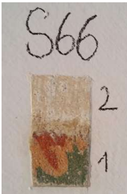
10. Stěna na stěně schodiště, vrstva originální malby překrytá šedým hlinkovým nátěrem
