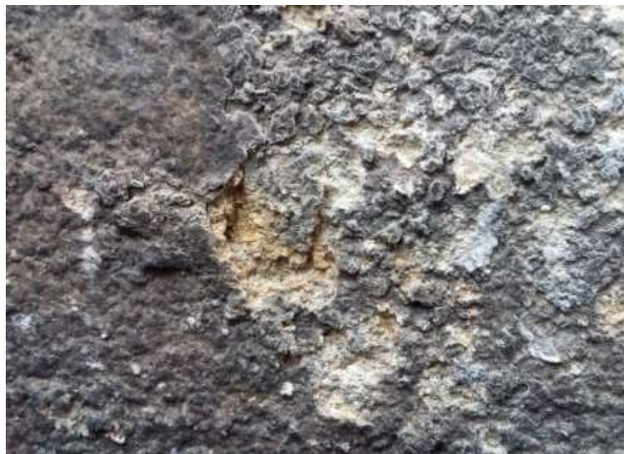
31. Degradace původního kamene pod nanesenou cementovou stěrkou
