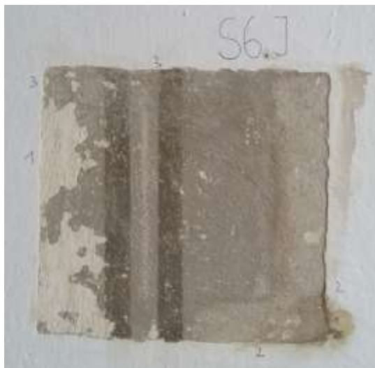
15. Sonda na jižním schodišti, 1. barevná vrstva – bílá vápenná, 2. šedá vápenná, 3. dekorativní hlinková malba
