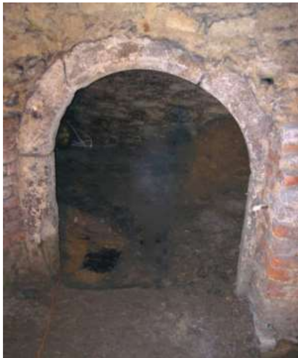
39. Portál vedoucí do větší místnosti sklepa, některé části kamene jsou uvolněné
