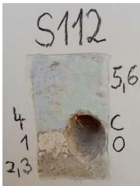
22. Sonda v soklové části arkádové chodby, cihlový podklad, omítka s jemně zrnitým povrchem a 1. světle okrovou a šesti mladšími barevnými vrstvami
