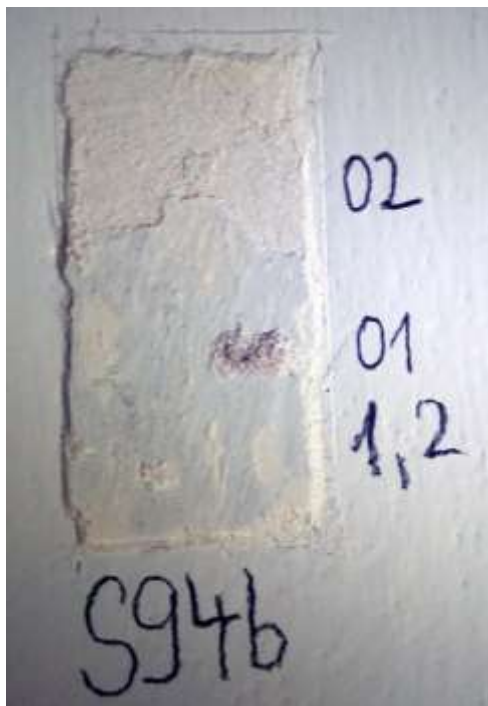
19. Sonda v záhybu chodby před pánskými WC, 1. vrstva - na jemně zrnité omítce světlá bleděmodrá barevná vrstva se zbytky vápenné přemalby je přeštukována do současné podoby s bílou úpravou
