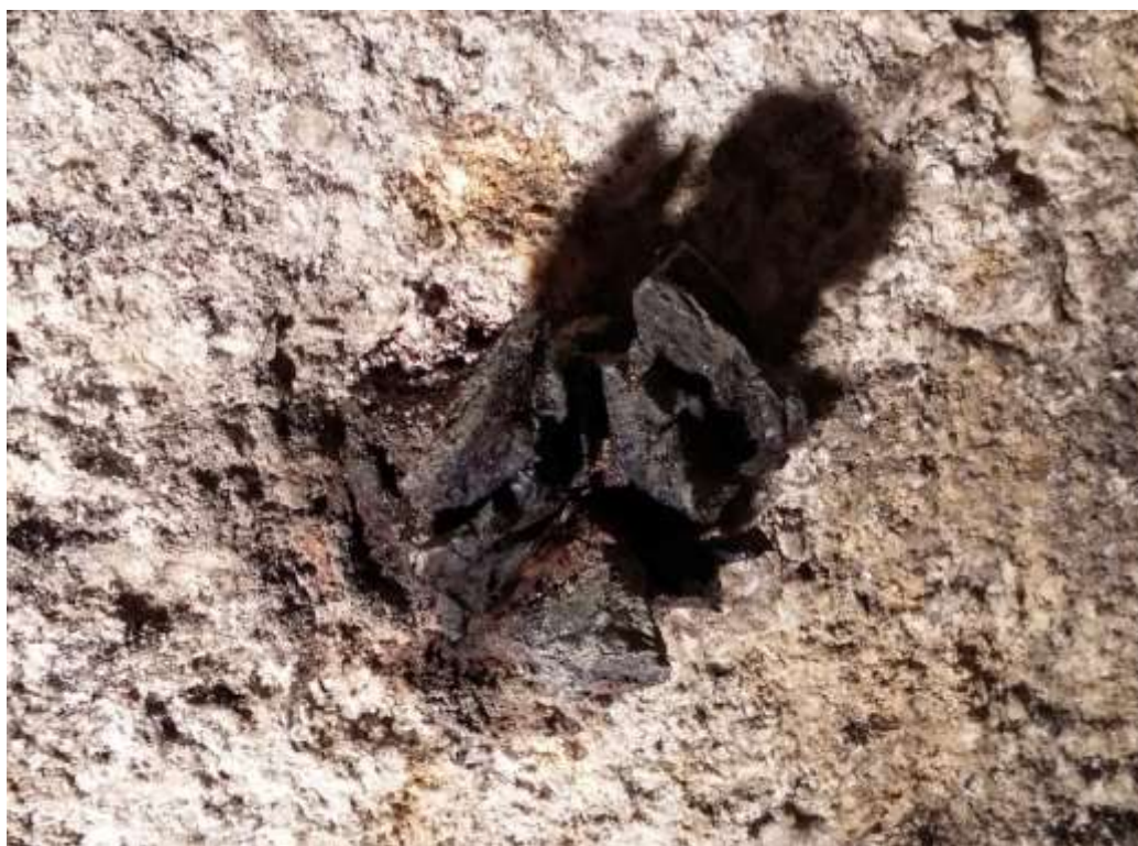
38. Kovový čep zasazený do kamene, rozštěpený vlivem vlhkosti, pokrytý rží
