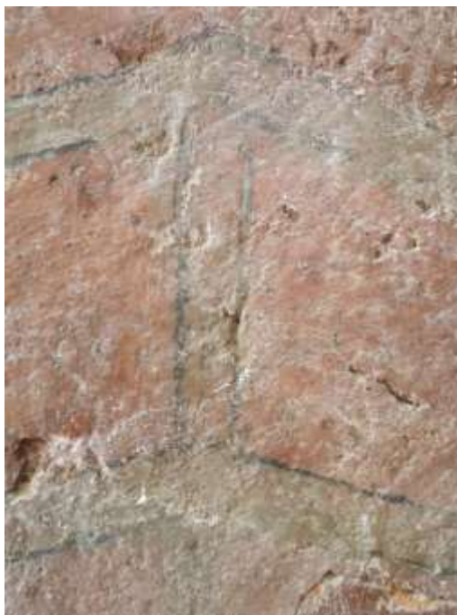
28. Cihlová část kleneb čelem k hlavnímu vchodu je přetmelena a opatřena malovanou imitací
