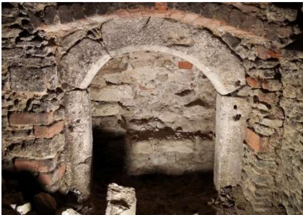
37. Portál s nikou, spáry mezi kameny tvořící klenbu jsou vyplněny kameny a maltou
