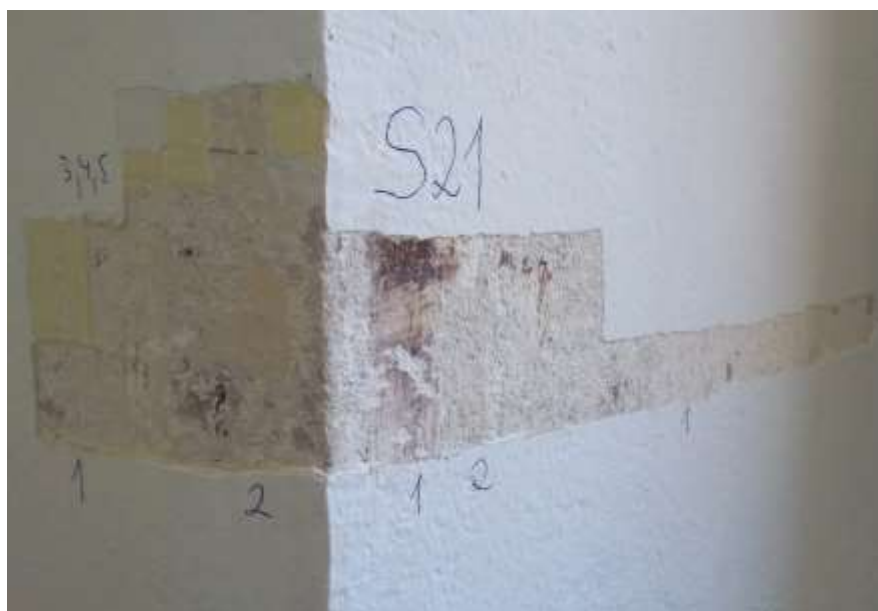
4. Sonda ve špaletě okna, vrstva 1 – vápenná barevná vrstva - hnědé rámování, bylo nalezeno v jediné ze zkoumaných špalet, vrstvy 2 až 5 – mladší monochromní nátěry
