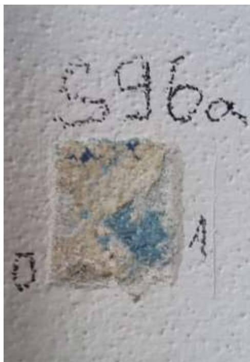
20. Sonda na stěně naproti oknům v jižním křídle chodeb 2. NP, zbytky dekorativní malby táhnoucí se v pásu pod záklopovým stropem
