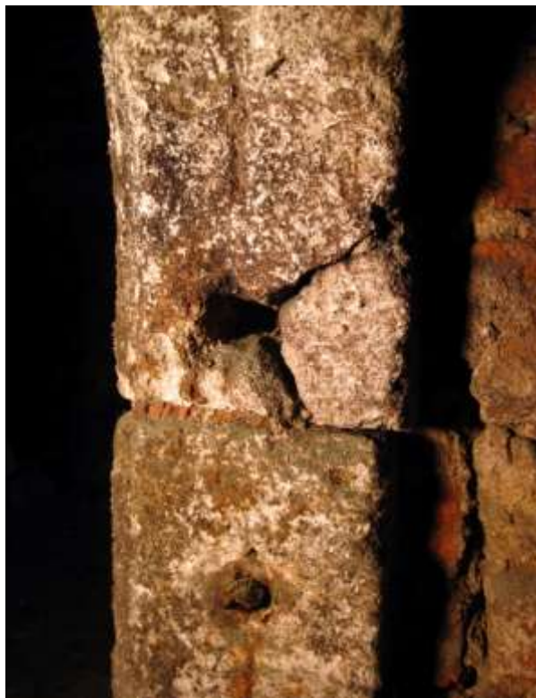
40. Portál vedoucí do větší místnosti sklepa, detail uvolněných částí kamene
