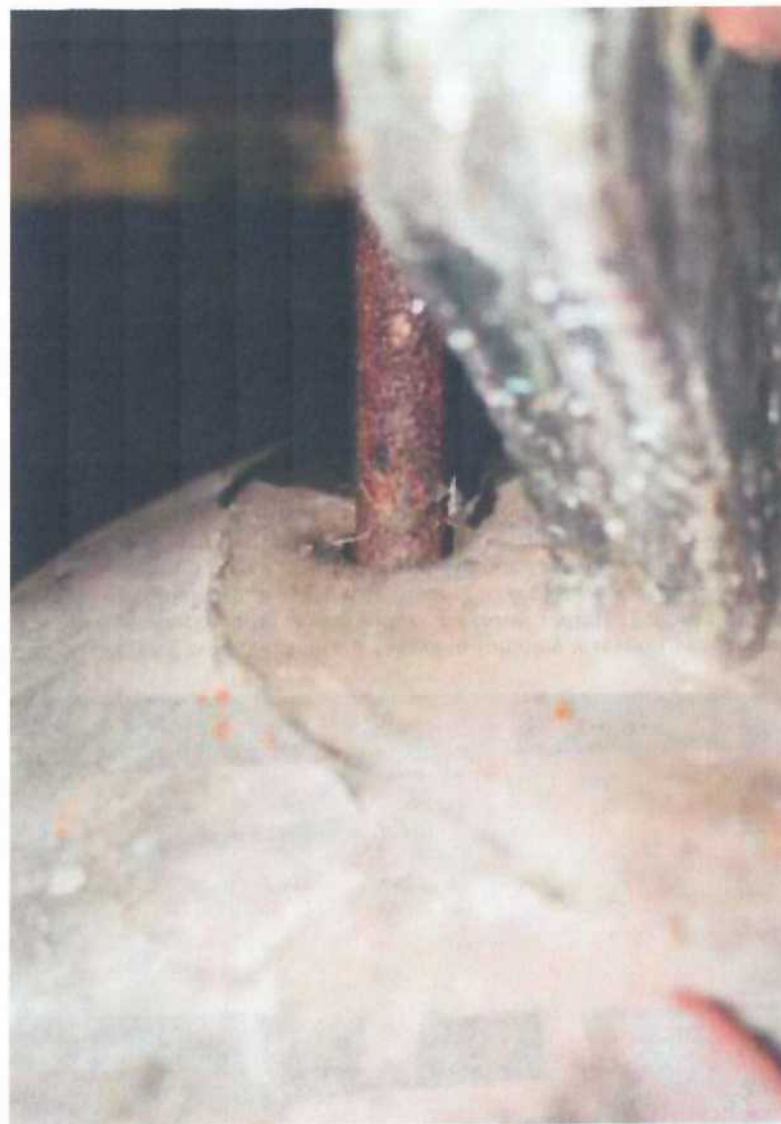
Obr. 7. Příklad provrtání čepce. Jde o zásah do hmoty zvonu, který nesmí být přípustěn.
