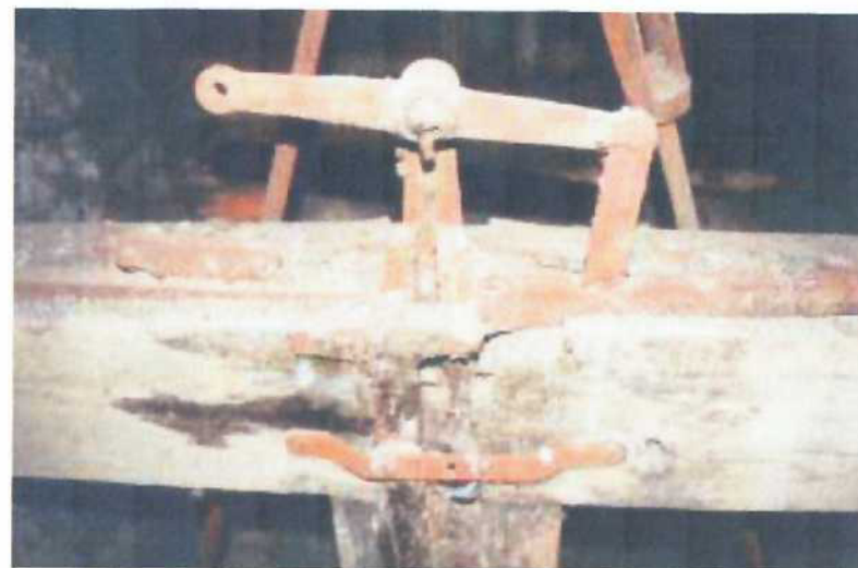
Obr. 9. Dřevěná zvonová stolice a takzvané rohatiny v severní věži kostela sv. Jana Nepomuckého na Skalce v Praze na Novém Městě. Pohled shora na zavěšení na rohatinách. Jsou vidět čelisti svírající čepy závěsu zvonu. Čelisti se pohybují nahoru a dolů a jsou spojeny vahadlem. Takové součásti dobového uložení zvonu je třeba považovat za technické řešení zasluhující – zvláště pokud je zachováno v provozu se zvonem – pozornost památkové péče.
