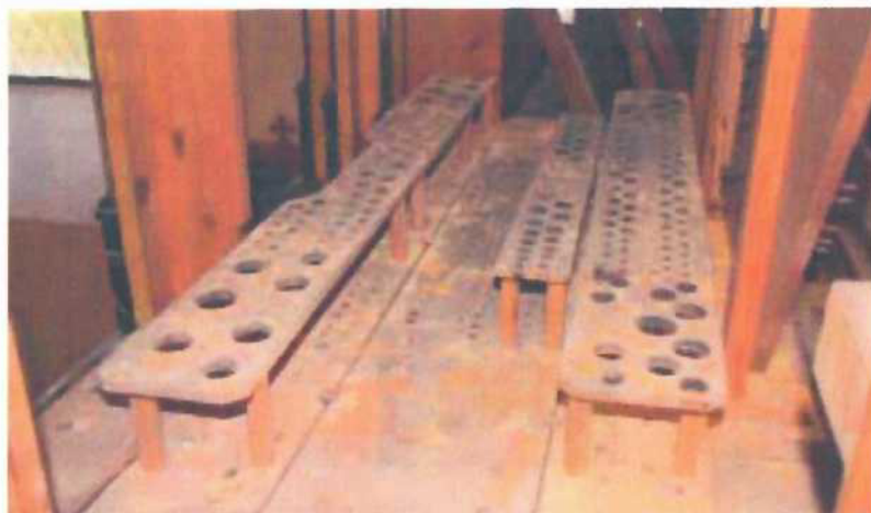
Obr. 22. Dlouhá Brtnice (okres Jihlava), kostel sv. Václava, varhany, Ludvík Nix, 1887. Stav po demontáži píšťal.
