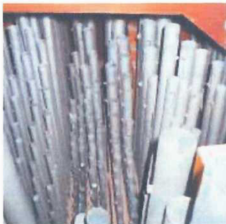
Obr. 9. Vlkoš (okres Hodonín), kostel Nanebevzetí Panny Marie, vyměněné píšťaly varhan.
