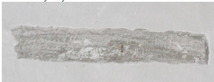
sonda VŠJV/1- východní špaleta okna na jihovýchodní stěně
