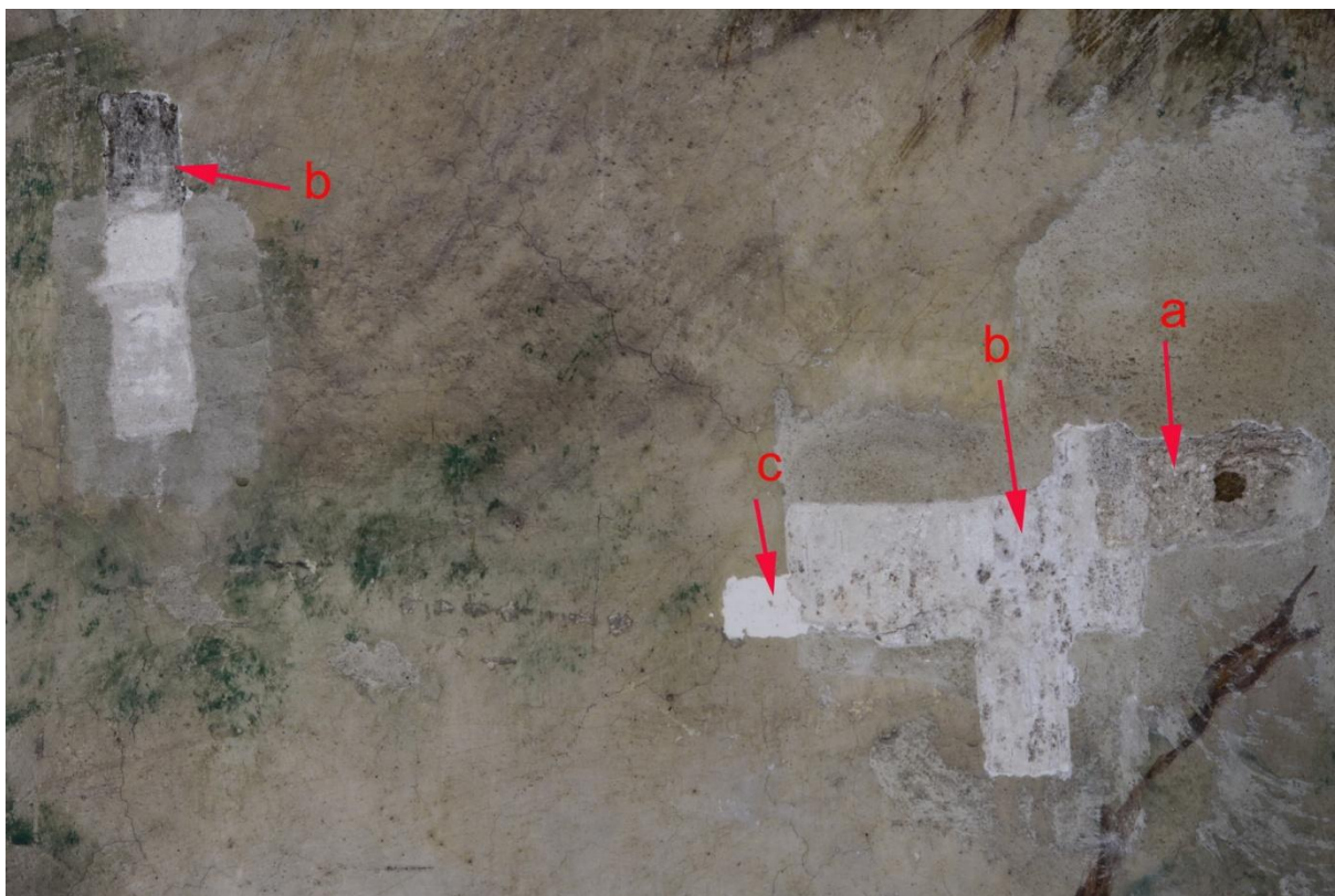
a)- jádrová hrubá vápenná omítka, b)- starší, plísň silně napadená vápenná utažená omítka c)- vápenný pačok (vrstva) pod figurální vápennou malbou po roce 1770
