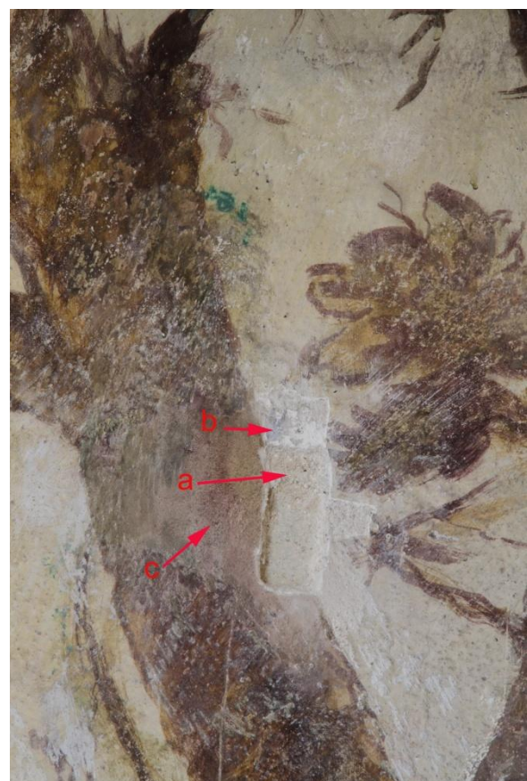
a)- jádrová hrubá vápenná omítka, b)- starší, plísň silně napadená vápenná utažená omítka c)- vápenný pačok (vrstva) pod figurální vápennou malbou po roce 1770
