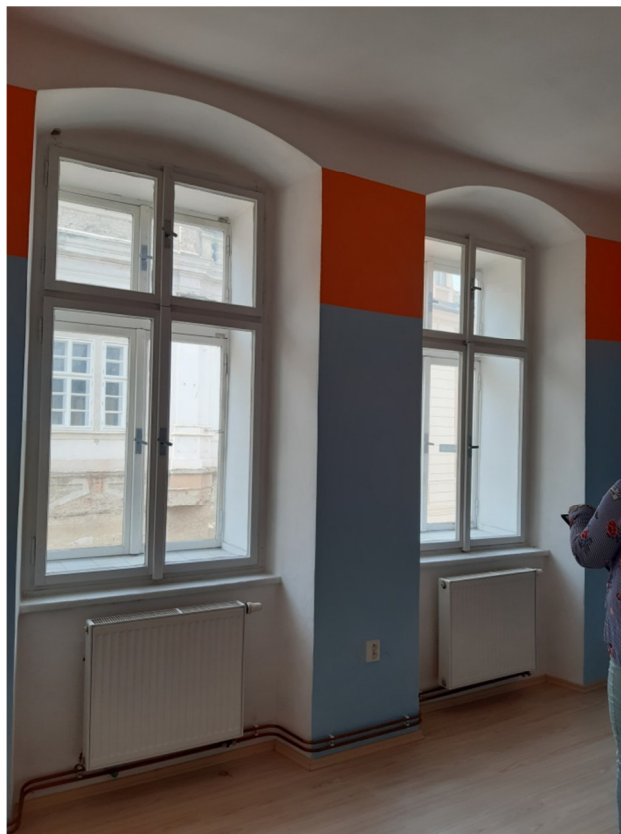
m.č. 2.06 – pokoj - okna
