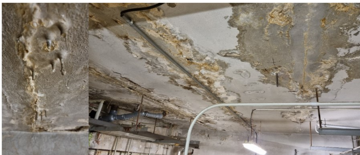
Obr. 7: Výkvěty na spodní straně stropní konstrukce
