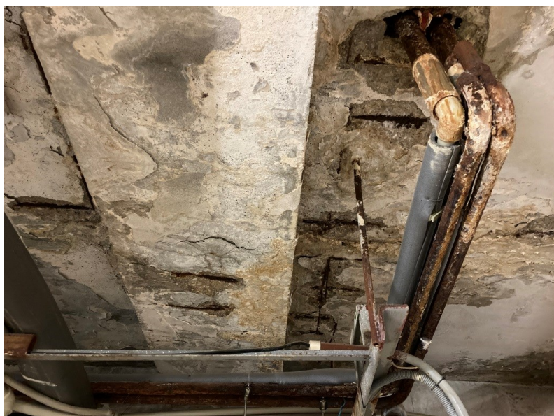
Obr. 15 Detail (1) narušené stropní konstrukce v 1.PP krytého bazénu.
