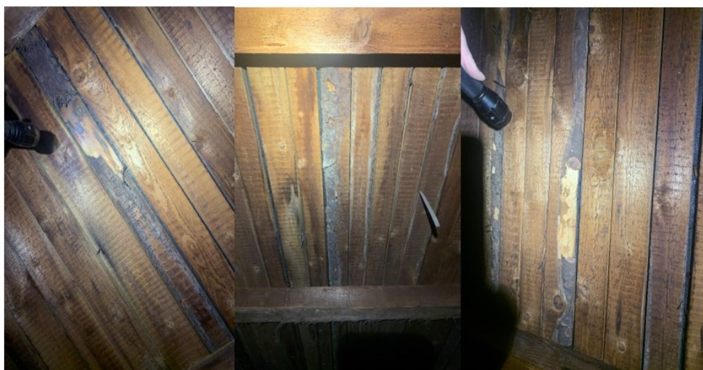
Obr. 19 Pohled na neodkorněné bednění napadené dřevokazným hmyzem
