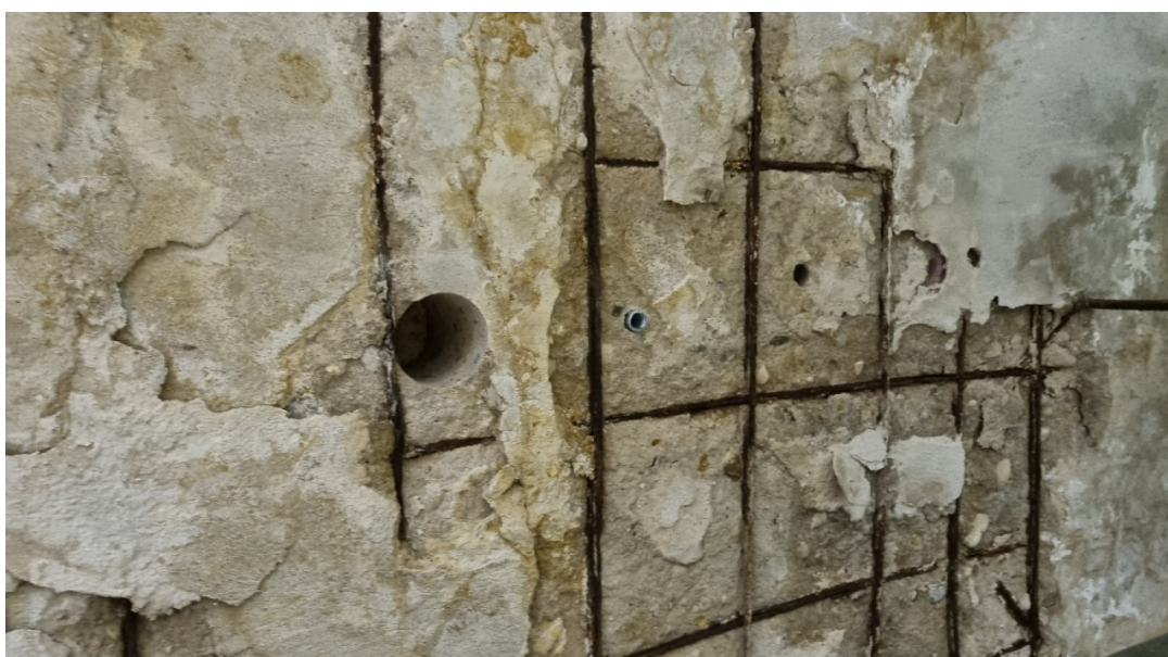
Obr. 10: Odhalená betonářská výztuž stropní konstrukce ochozu bazénu
