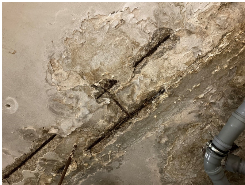
Obr. 14 Detail (2) narušené stropní konstrukce v 1.PP krytého bazénu.
