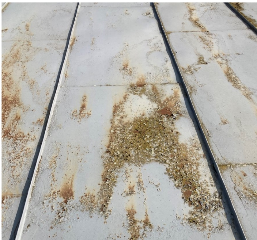
Obr. 3 Detail poškozené střešní krytiny krytého bazénu.
