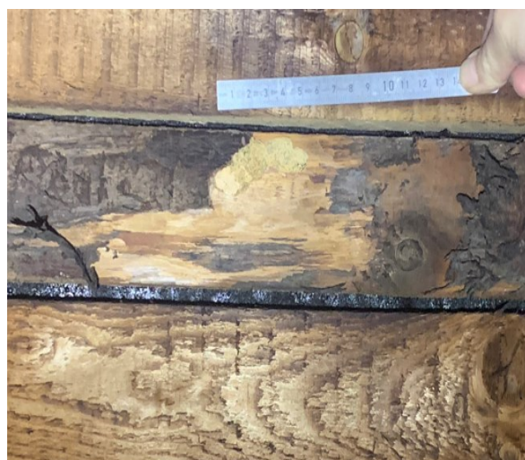
Obr. 23 Detailní pohled na neodkorněné bednění
