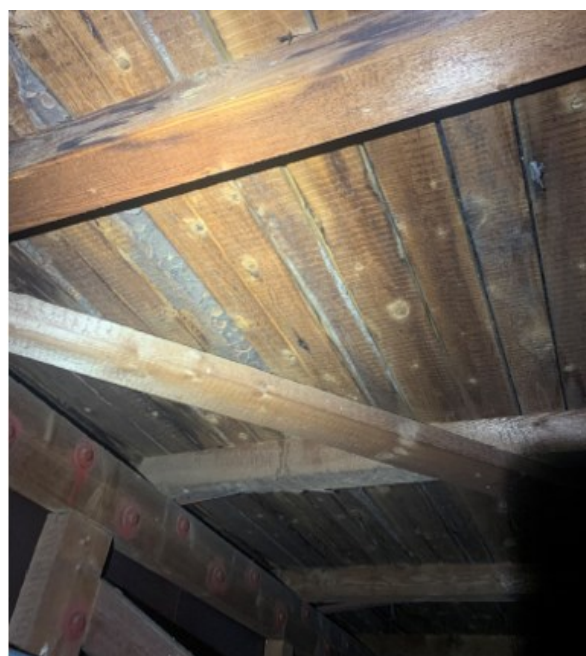
Obr.21 Stopy po zvýšené vlhkosti, neodkorněné bednění
