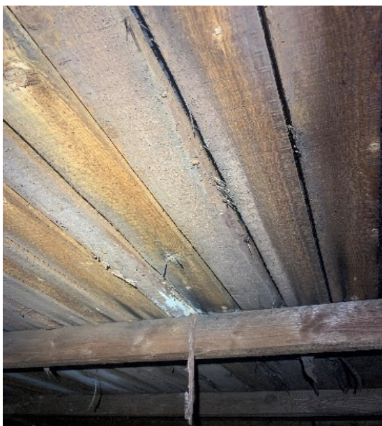
Obr. 27 Bednění ve styku s vaznicí napadené dřevokaznou houbou
