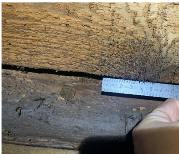
Obr. 30 Bednění napadené dřevokazným hmyzem a s ložiskem plísní
