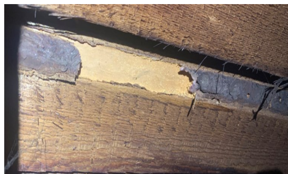
Obr. 24 Pohled na neodkorněné bednění napadené dřevokazným hmyzem
