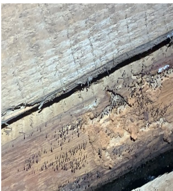
Obr. 31 Bednění napadené dřevokazným hmyzem a dřevokaznou houbou a s ložiskem plísní
