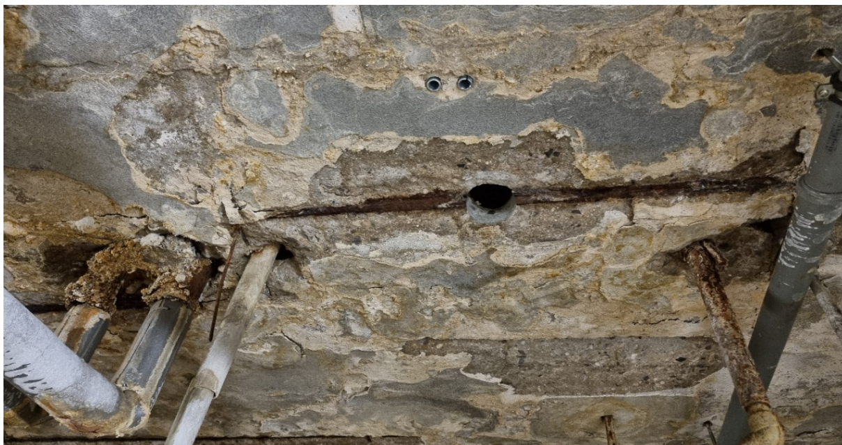
Obr. 8: Výkvěty na spodní straně stropní konstrukce
