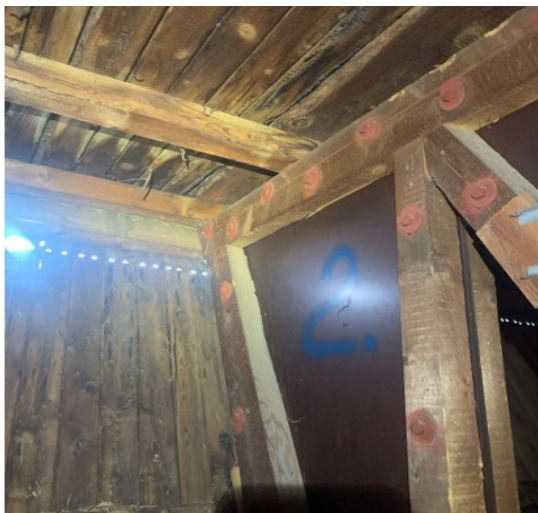
Obr. 22 Stopa po zatékání
