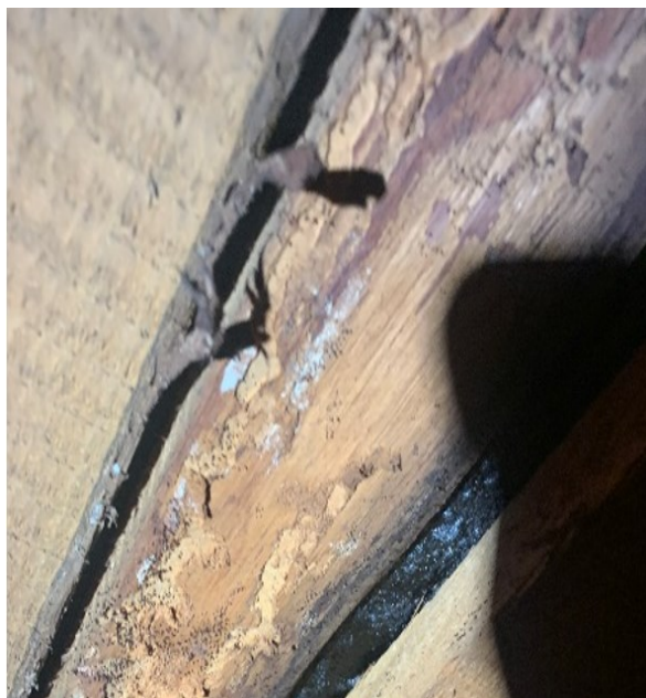
Obr. 31 Bednění napadené dřevokazným hmyzem a dřevokaznou houbou a s ložiskem plísní
