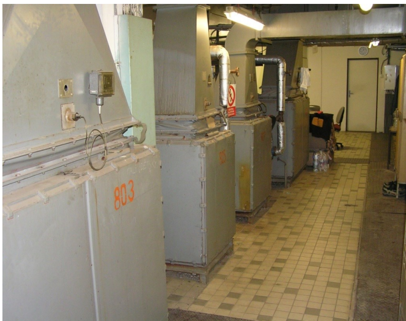
Obr. 8 Strojovna VZT v 1.PP – nefunkční přívodní jednotky.
