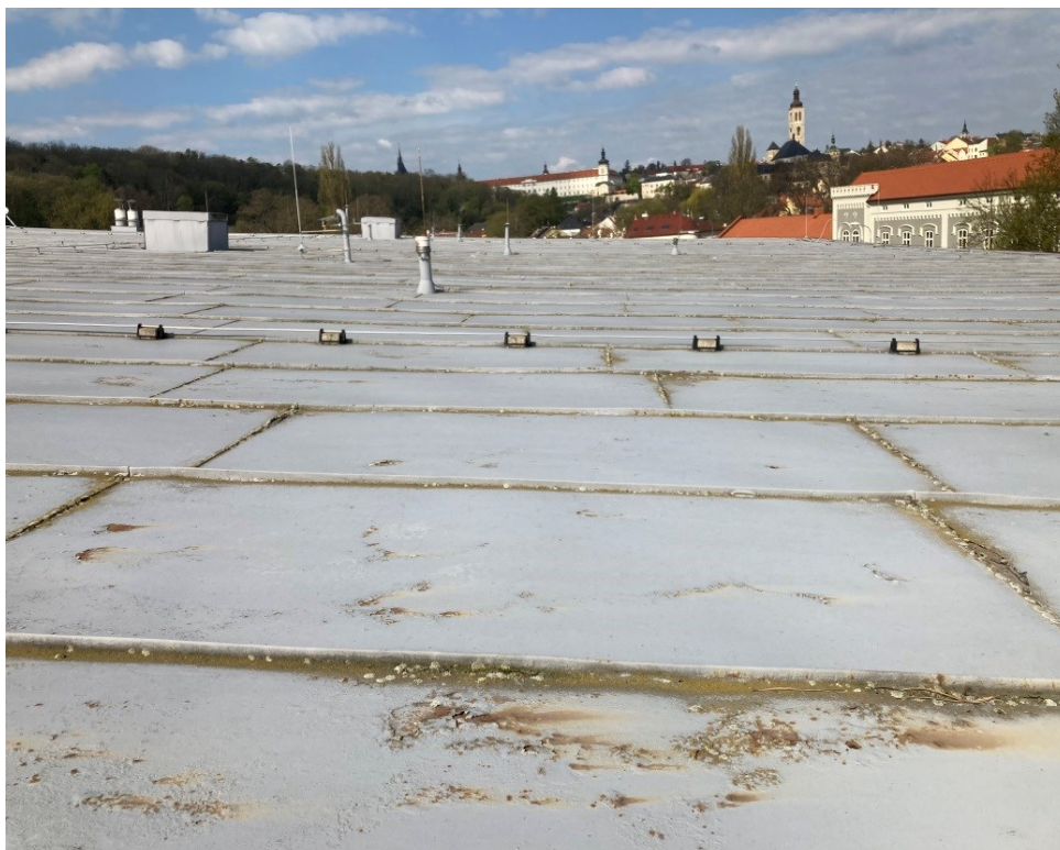
Obr. 2 Značně poškozená střešní krytina krytého bazénu.
