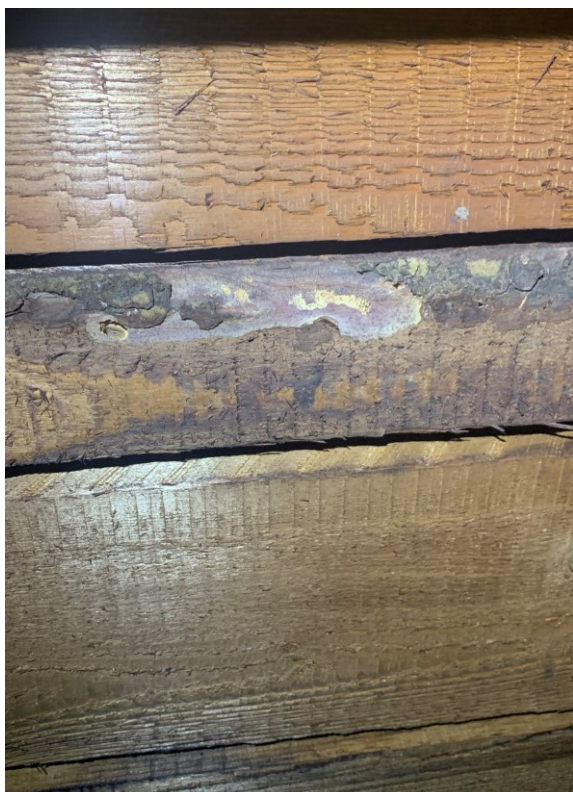
Obr. 24 Pohled na neodkorněné bednění napadené dřevokazným hmyzem
