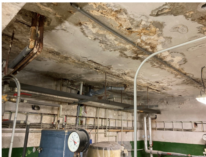
Obr. 13 Narušená stropní konstrukce v 1.PP
