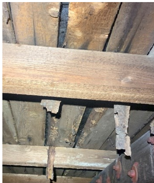
Obr. 28 Neodkorněné bednění napadené dřevokazným hmyzem
