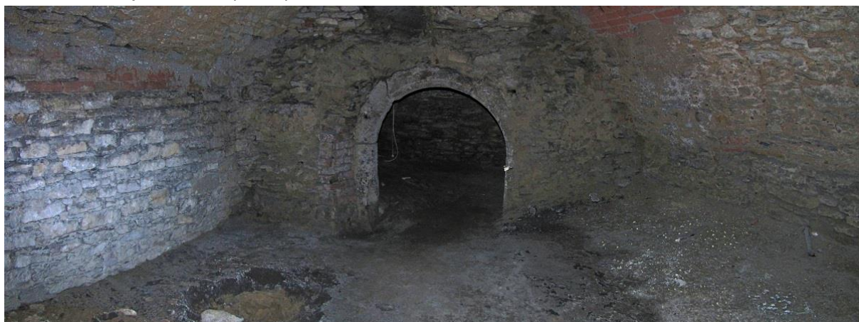
Obr. č. 5: Stávající stav sklepních prostor
