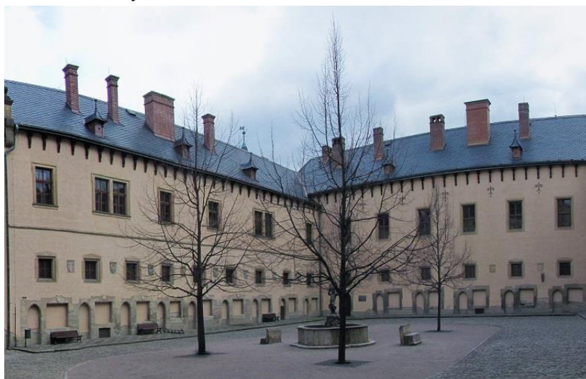
Obr. č. 4: Stávající stav šmiten na nádvoří
