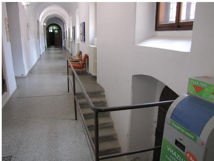
Obr. č. 10: stávající stav - chodby
