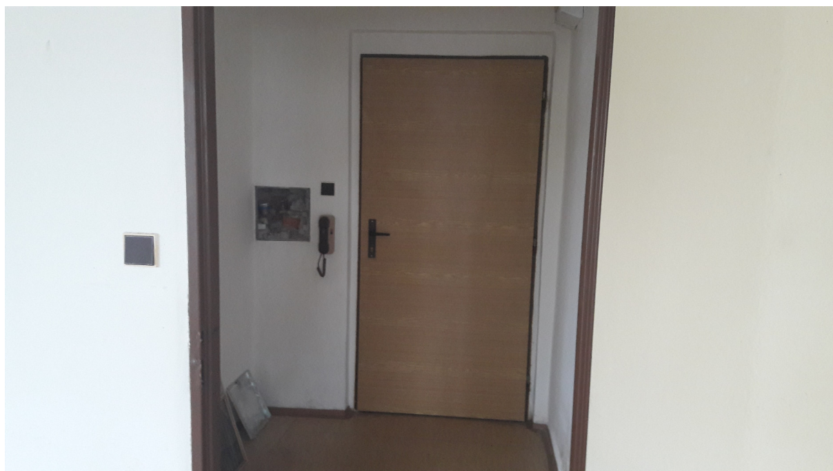
Stávající pokoj – pohled do předsíně a na stěnu, kde budou luxfery
