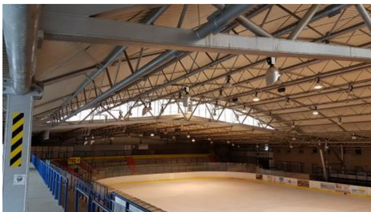
Pohled na ocelovou nosnou konstrukci haly
