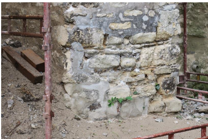
stav líce při odstraňování cementu ze spár
