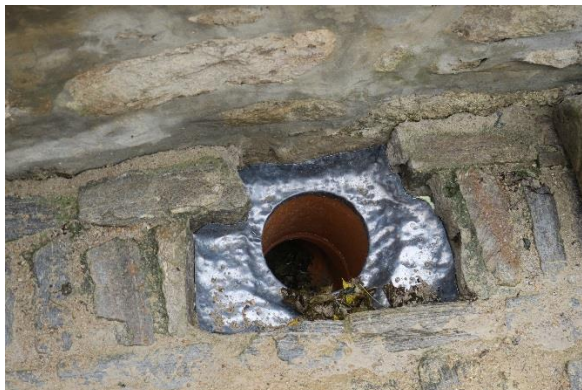
Vyplechování kamenného chrliče a novodurové trubky – stav před doplněním kamenů kanálku a kovaných kramlí
