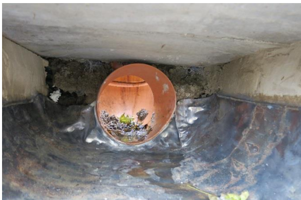
Vyplechování kamenného chrliče a novodurové trubky – stav před doplněním kamenů kanálku a kovaných kramlí
