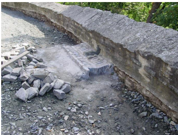
stav při provádění odvodního kanálku (za foto děkuji panu D. Novotnému z KÚ SČK)
